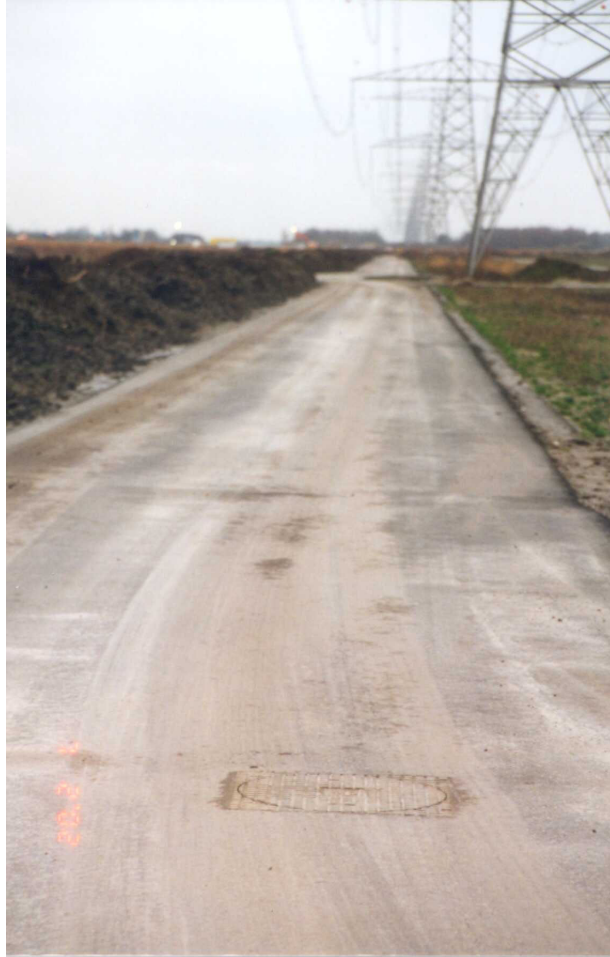
Industrieterrein Flevopoort Lelystad Weg met bluswaterriool onder 380 kV hoogspanningsverbinding
